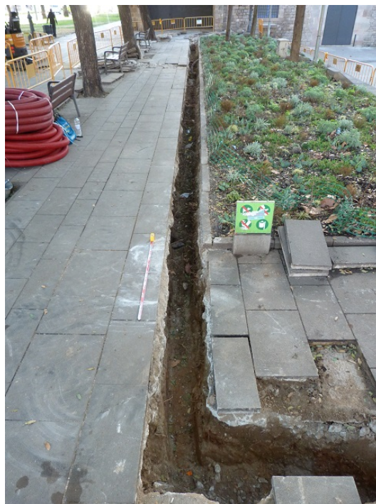
Vista general de la Rasa 200 una vegada finalitzats els treballs d'excavació
