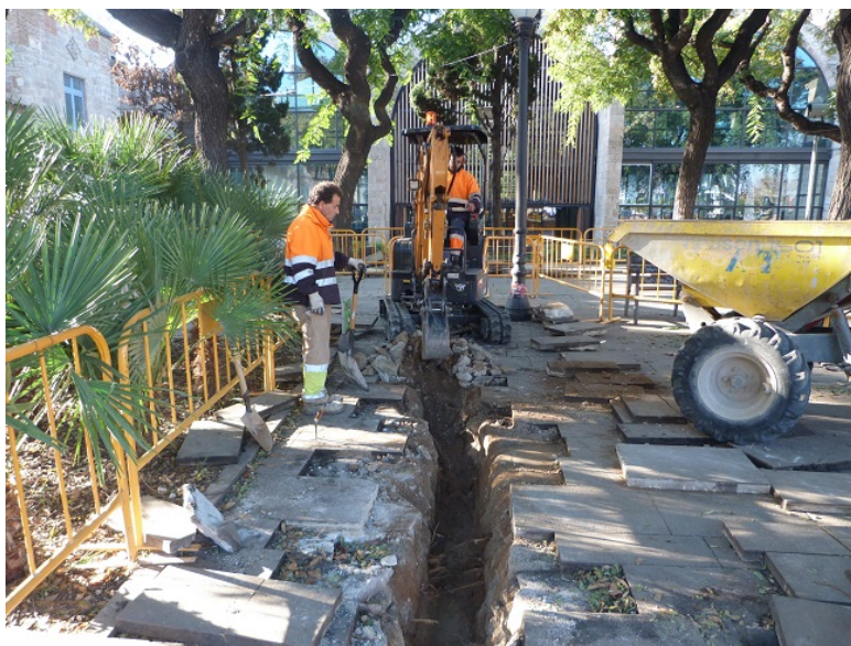
Vista dels treballs d'excavació de la Rasa 100
