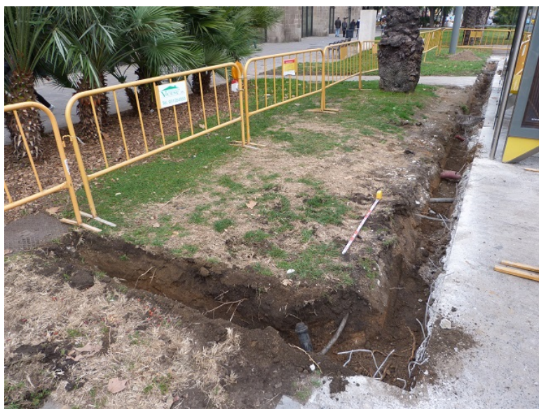
Vista general de la Rasa 100 una vegada finalitzats els treballs d'excavació
