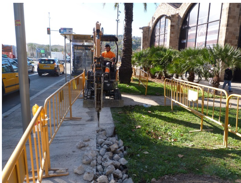
Vista general dels treballs d'extracció del paviment de formigó de la vorera
