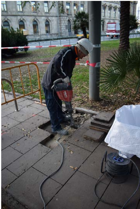
Vista dels treballs d'extracció del paviment de la vorera i la seva preparació de formigó
