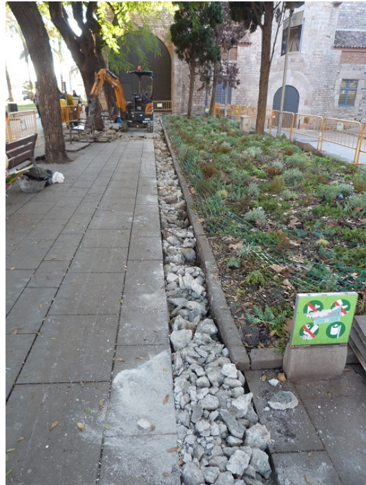
Vista dels treballs d'extracció del paviment de la vorera i la seva preparació de formigó
